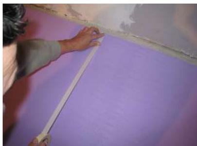
Tous les joints entre les plaques de directionnel de flux sont obturés avec l'adhésif en 19 mm.
