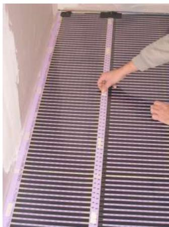
Les fils d'alimentation doivent cheminer dans la zone de 35 mm prévue à cet effet et maintenus en place avec la colle en cartouche. Ils seront ramenés dans la boîte de dérivation et raccordés par un électricien qualifié via les bornes WAGO prévues à cet effet et livrées avec le kit.
