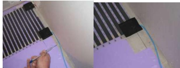
Chaque élément chauffant est fixé soigneusement sur sa longueur et à ses 2 extrémités avec l'adhésif 19mm.
