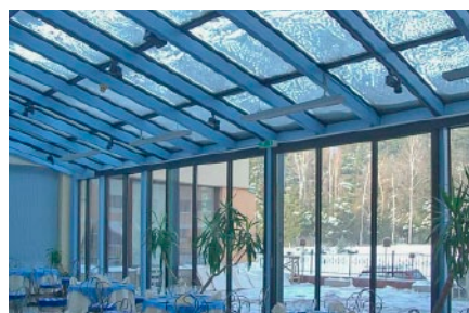
Restaurant , Russie Panneaux rayonnants
