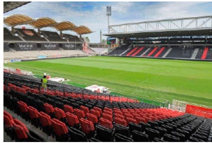
Stade de foot Matmut Lyon Câble chauffant
