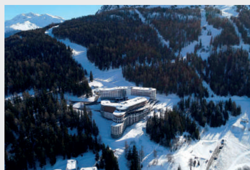
Club Med Les Arcs Câble chauffant, Plafond chauffant, Déneigement
