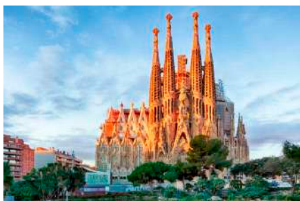
Sagrada Familia , Barcelone, Espagne Câble chauffant
